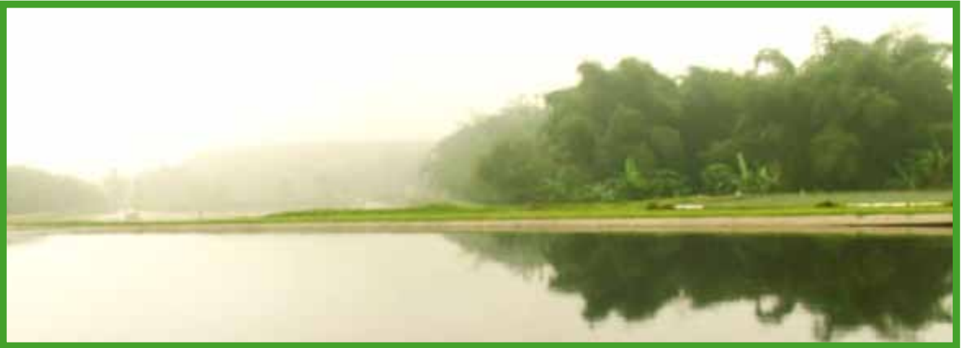
Un des bassins de lagunage à GREL. Effluent treatment pond at GREL
